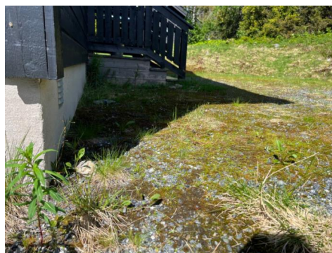
Terrengfall er flatt mot bygning
