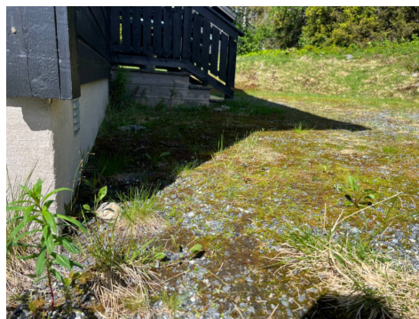
Terrengfall er flatt mot bygning
