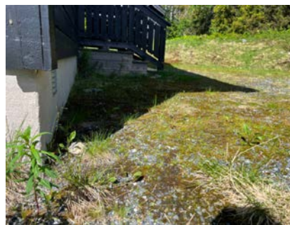
Terrengfall er flatt mot bygning
