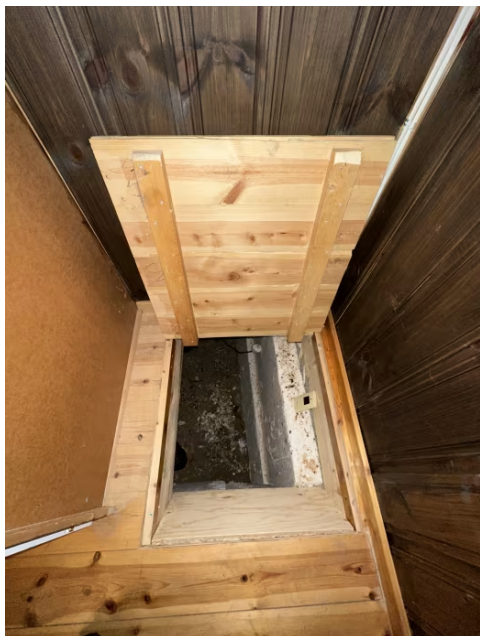
Adkomst til rom under terreng via luke i gulv i entre.
