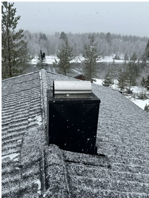
Viser pipehatt med regnskjerm.
