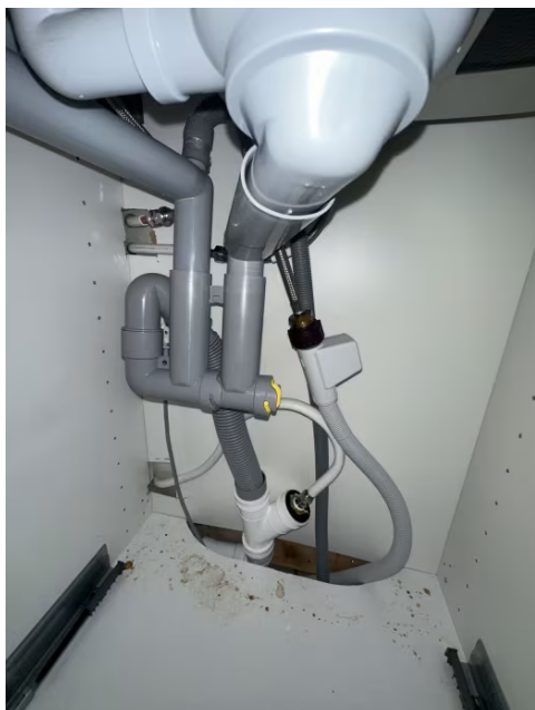
Viser vann og avløpsinstallasjoner under kum
