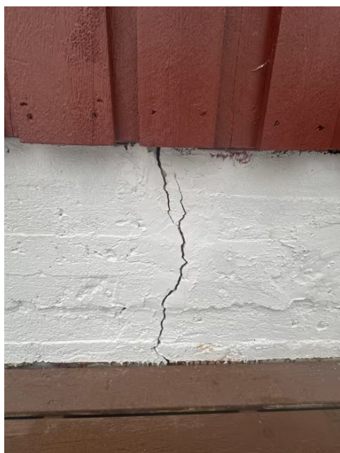
Viser sprekker i ringmur.
