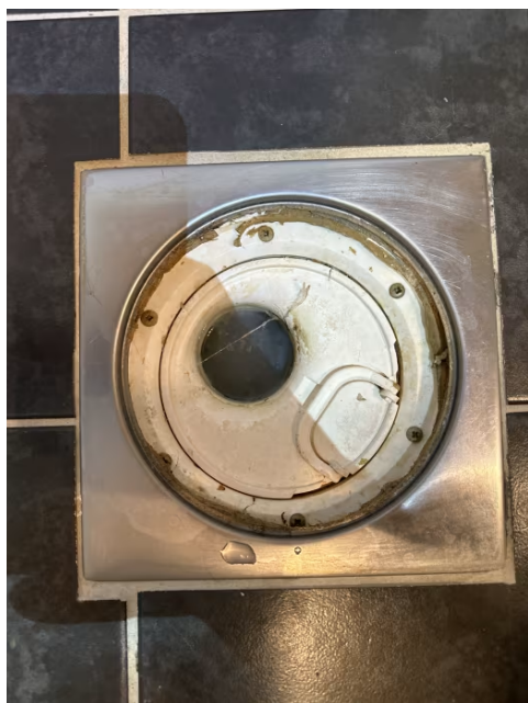
Viser sluk i dusjsonen.
