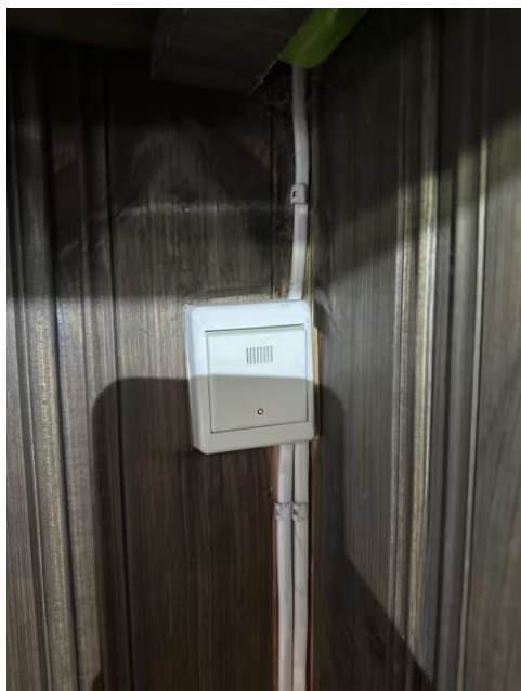
Byter for varmekabel i vannrør.
