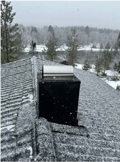
Viser pipehatt med regnskjerm.
