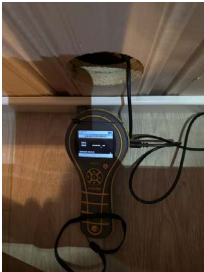
Det er foretatt hulltaking med 73 mm hullbor fra tilstøtende rom (soverom).
