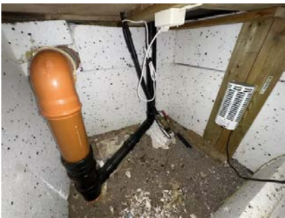
Viser avløpsrør i rom under terreng.
