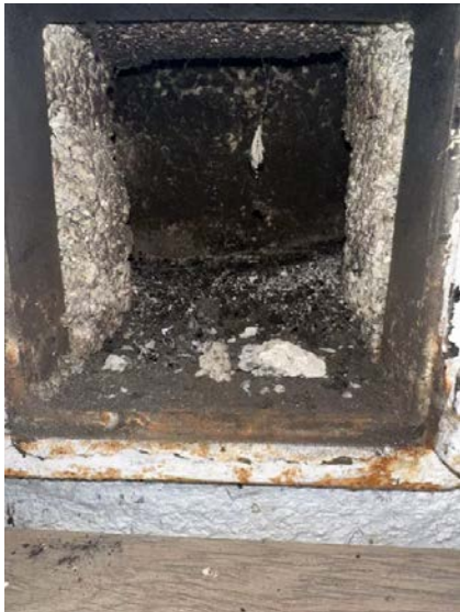
Viser sotluke bak innredning på kjøkkenet.
