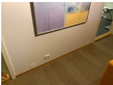
Hull ble plombert med plastlokk.
