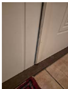
Liten åpning mellom dørbladene.
