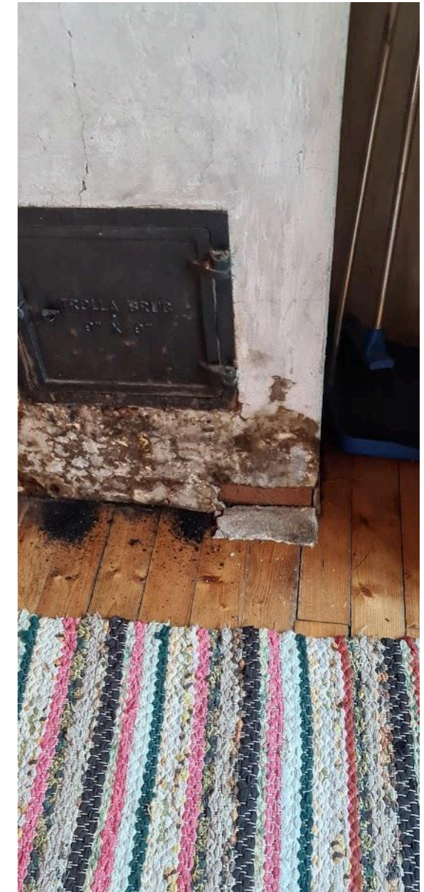
Merker etter fuktskade og puss har løsnet på pipe ned mot gulv. Manglende beskyttelse på gulv under feie/sotluke. Målte fuktig mellom feie/sotluke og gulv.
