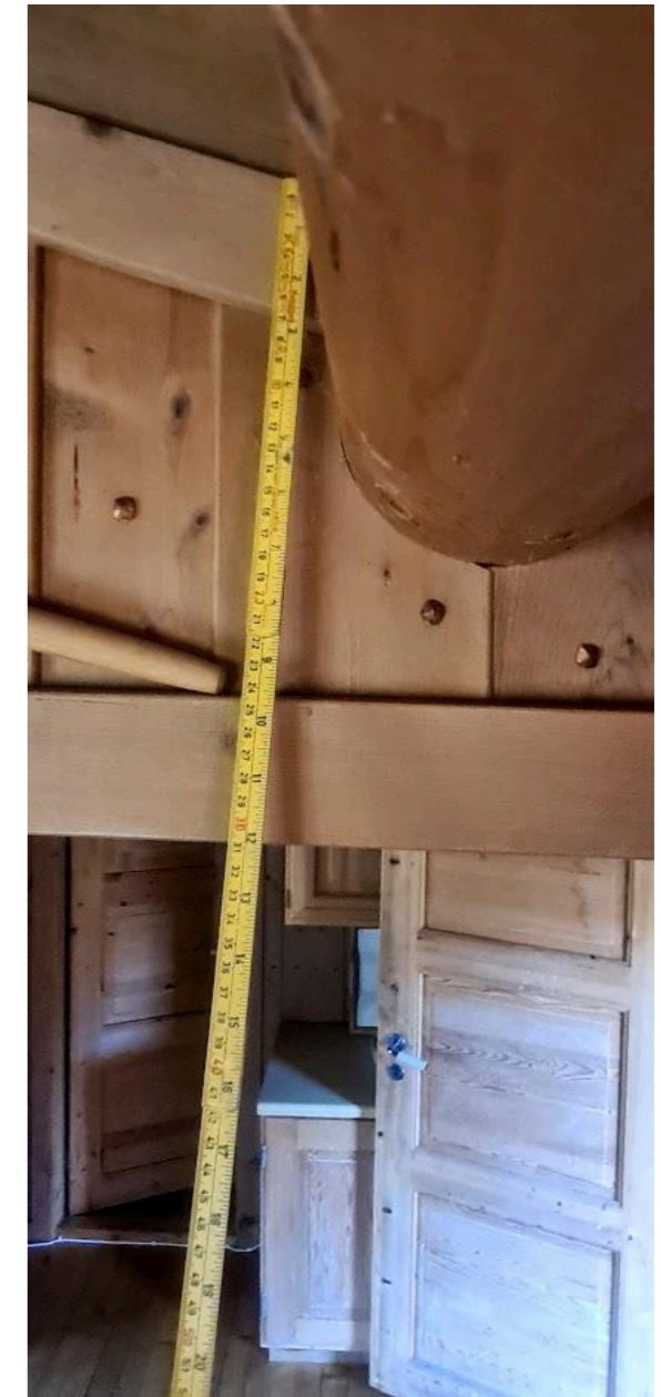
Takås over åpning inntil kjøkken fra stue.
