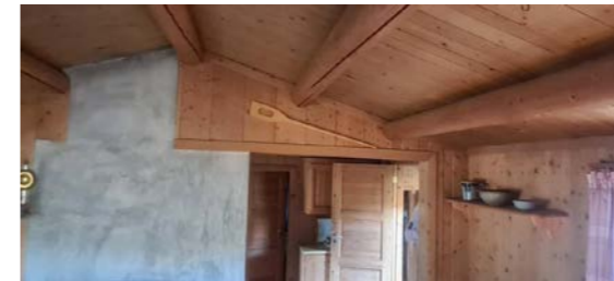
Takås over åpning inntil kjøkken er det liten bæring under takås; 120-130mm opplegg under takås.
