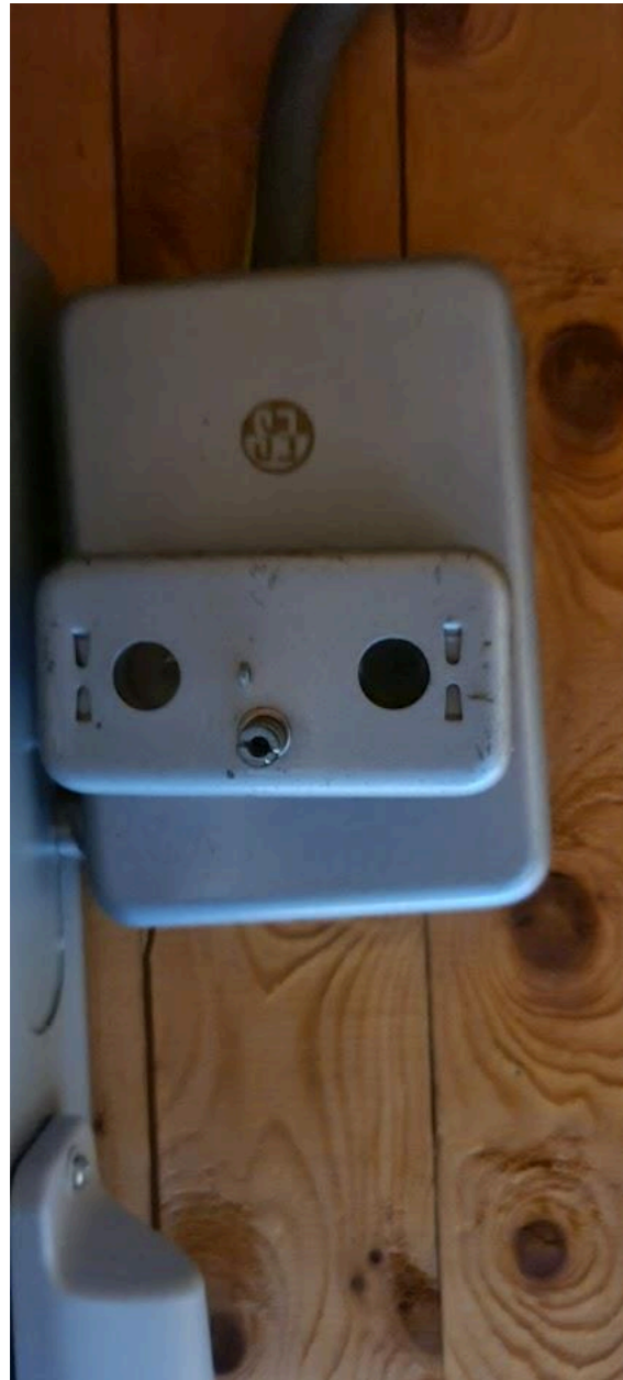
Hovedsikring 2x3 Ampere
