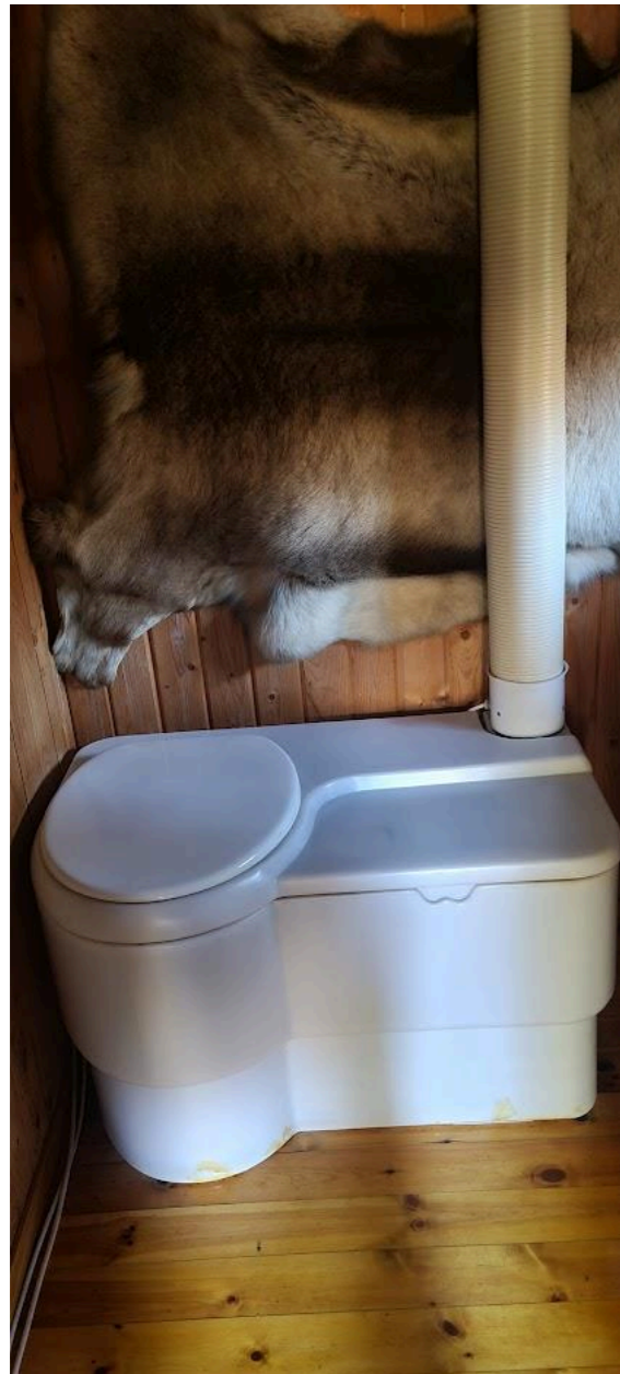
Biologisk toalett med ventilering fra kammer til over tak.
