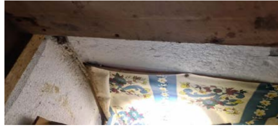
Isopor på innvendig side av vegger i kjeller rom.
