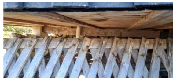
Synlig stubbeloft under bjelkelag.
