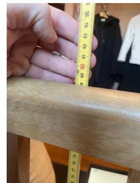
Høyde rekkverk trapp ned til kjeller under 90 cm
