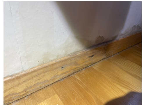
Vegg/gulv soverom mot nord.
