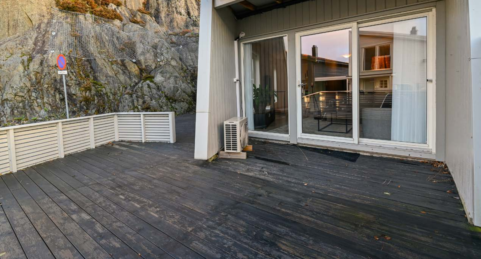
Boligen er utstyrt med en stor terrasse.
