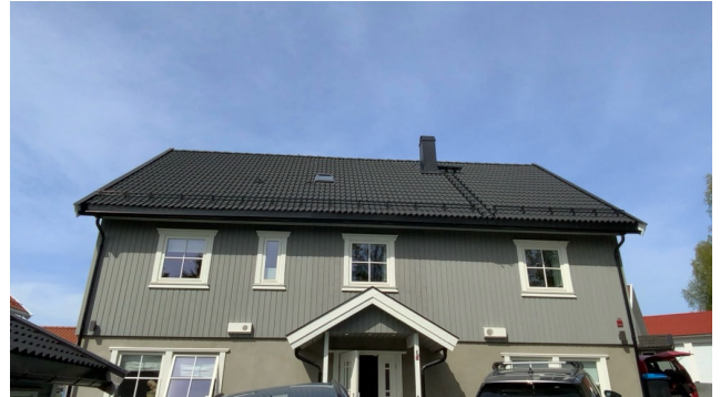
Besiktigelse av taktekte.
