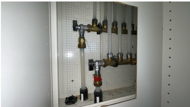
Besiktigelse av røropplegg.
