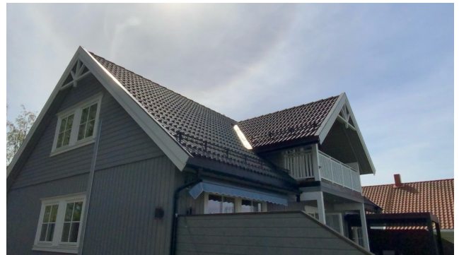
Besiktigelse av taktekte.
