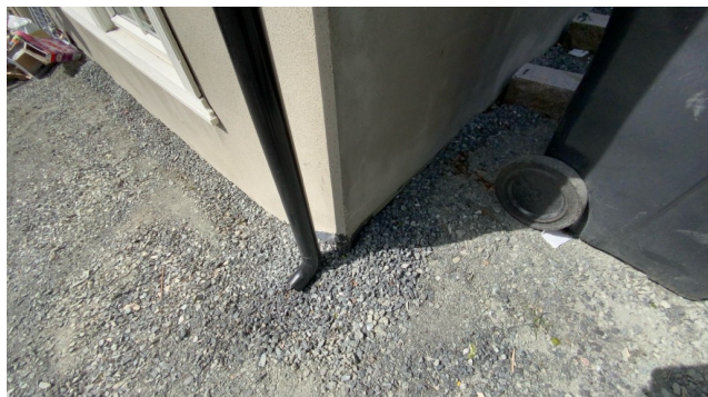
Kontroll av drenering/fuksikring.
