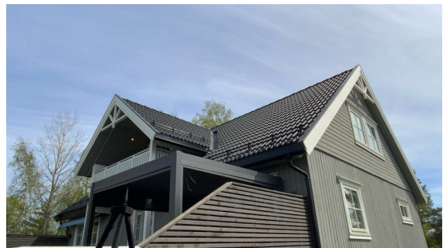
Besiktigelse av taktekte.
