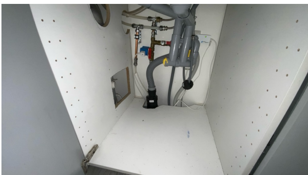
Besiktigelse av røropplegg.
