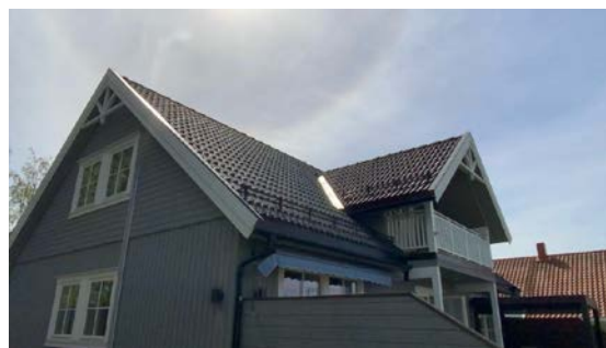
Besiktigelse av taktekk.
