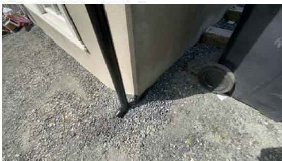
Kontroll av drenering/fuktsikring.
