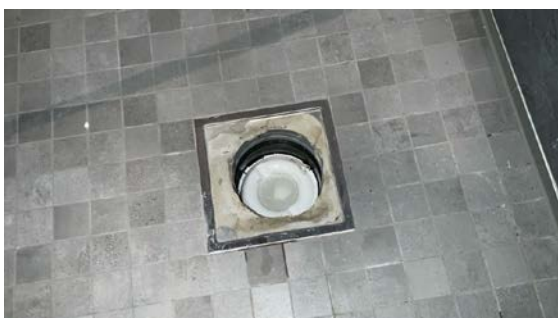
Kontroll av sluk.
