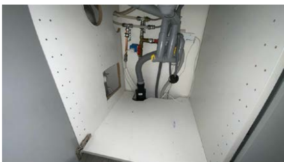
Besiktigelse av røropplegg.
