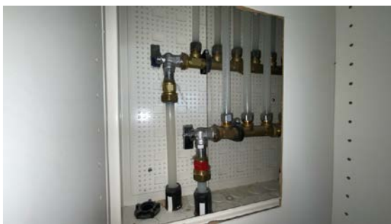
Besiktigelse av røropplegg.
