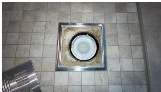
Kontroll av sluk.
