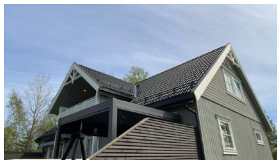
Besiktigelse av taktekk.
