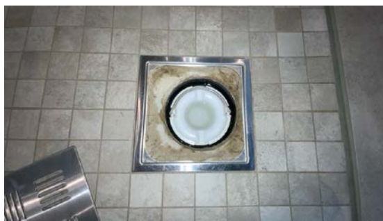
Kontroll av sluk.
