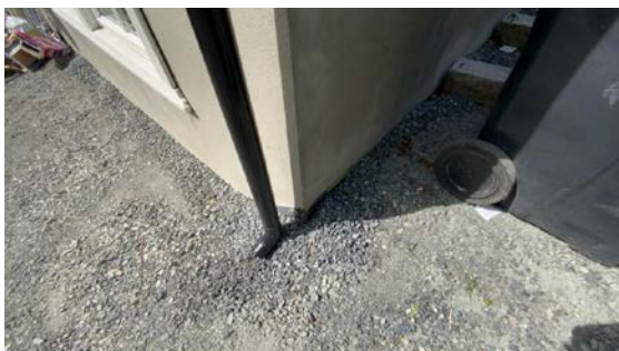
Kontroll av drenering/fuktsikring.
