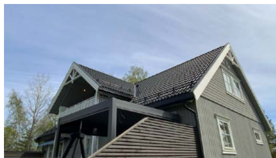
Besiktigelse av taktekk.
