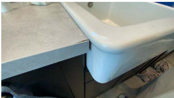
Mindre skade på benkeplate.
