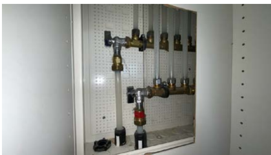
Besiktigelse av røropplegg.
