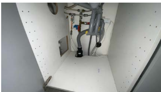
Besiktigelse av røropplegg.
