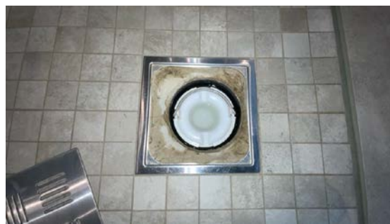
Kontroll av sluk.
