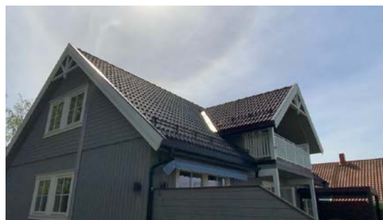
Besiktigelse av taktekk.
