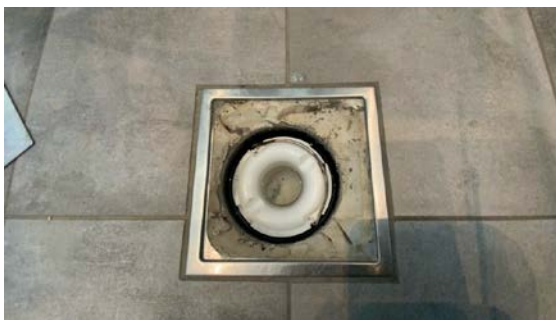
Kontroll av sluk.
