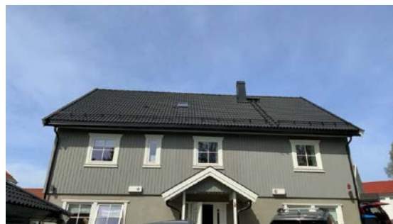
Besiktigelse av taktekk.
