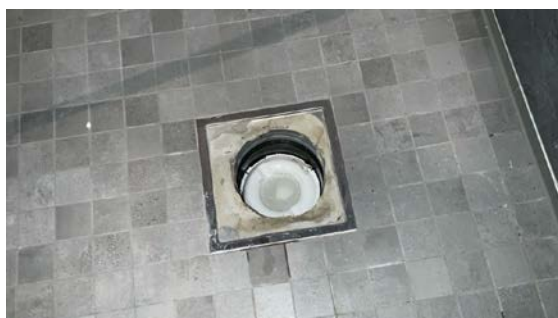
Kontroll av sluk.
