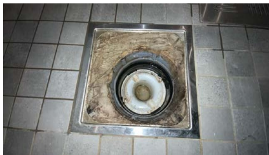
Kontroll av sluk.
