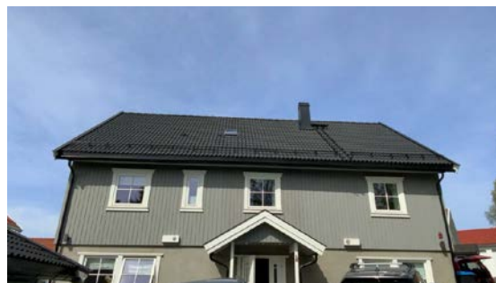
Besiktigelse av taktekke.
