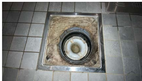
Kontroll av sluk.
