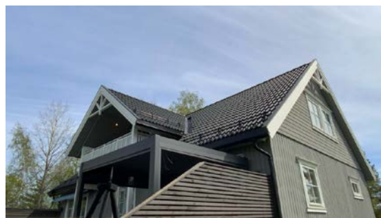
Besiktigelse av taktekke.
