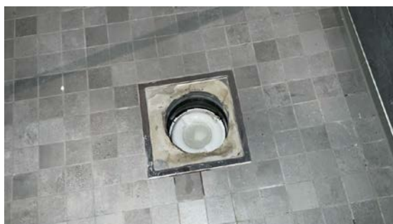
Kontroll av sluk.
