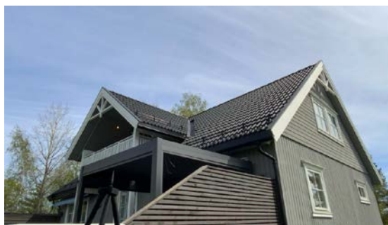
Besiktigelse av taktekke.
