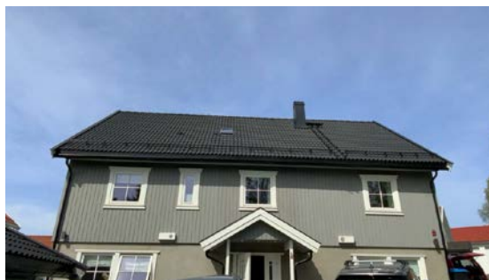
Besiktigelse av taktekke.
