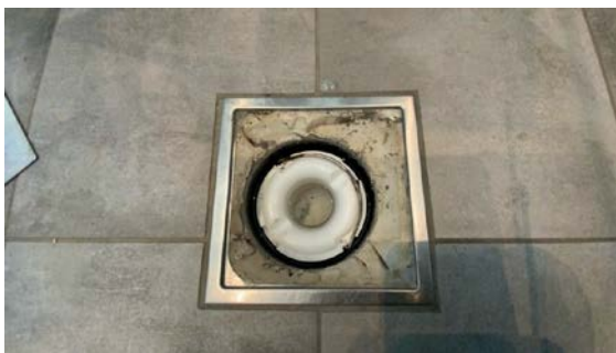
Kontroll av sluk.
