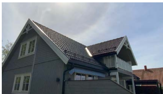
Besiktigelse av taktekke.
