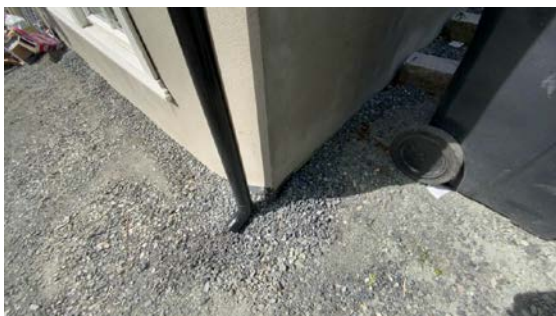
Kontroll av drenering/fuktsikring.
