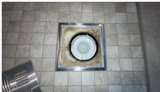
Kontroll av sluk.
