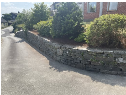
Forstøtningsmur til hage.
