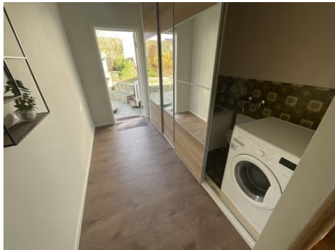
Entre og vaskerom har blitt delt opp med skyvedører.
