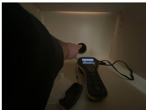
Hulltaking utført fra tilstøtende rom. Bilde som vises på apparatet tilsier et målte verdier er under 7%. Det er registrert at det er brukt plastfolie i konstruksjonen mot våtrom.
