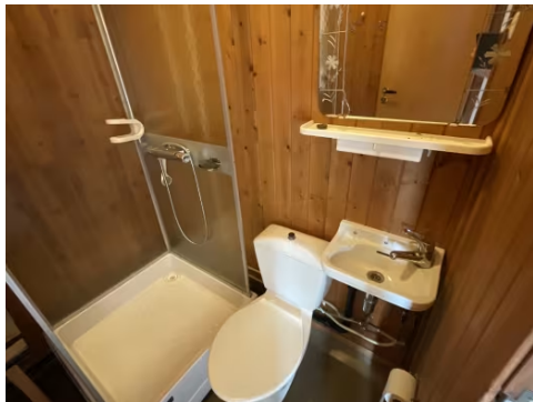
Panel på vegger, ikke egnet i våtsone, det mangler dør/forheng på dusjkabinett, ved bruk vil vann havne utenfor dusjkabinett.
