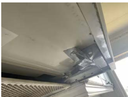
Avtrekk på ventilator fungerer, men den har blitt fikset på provisorisk med teip.
