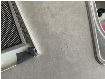
Skade i benkeplate.
