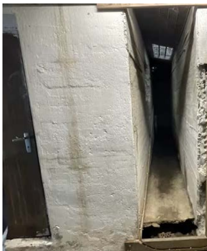
Ekstra grunnmur etablert under påbygging i 1985. Det er et hulrom der passasje starter. Ukjent om denne er godkjent den er ikke synlig på tegning.
