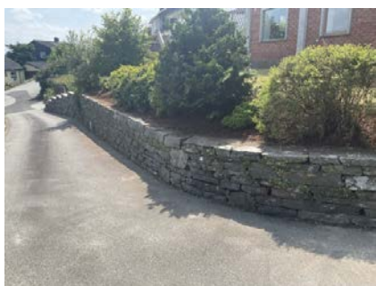
Forstøtningsmur til hage.
