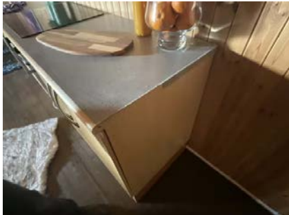
Skade i ende laminering av benkeplate.
