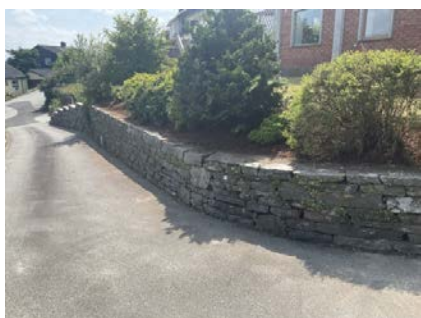
Forstøtningsmur til hage.
