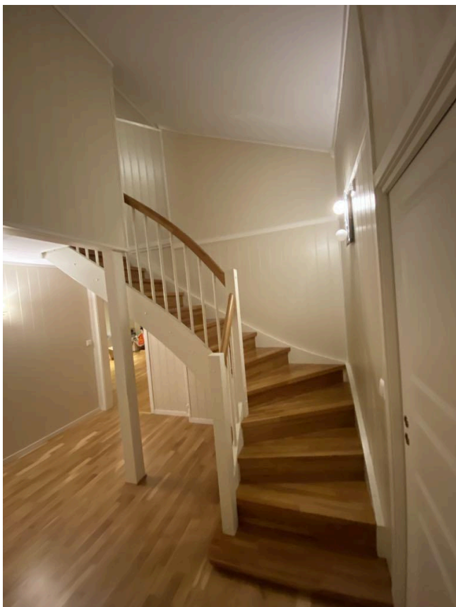
Tretrapp med sving mellom 1. og 2.etasje
