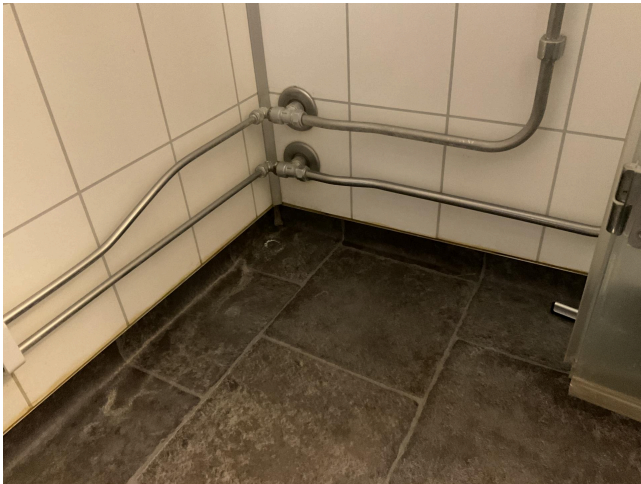
Gjennomgangsrør i dusjsone
