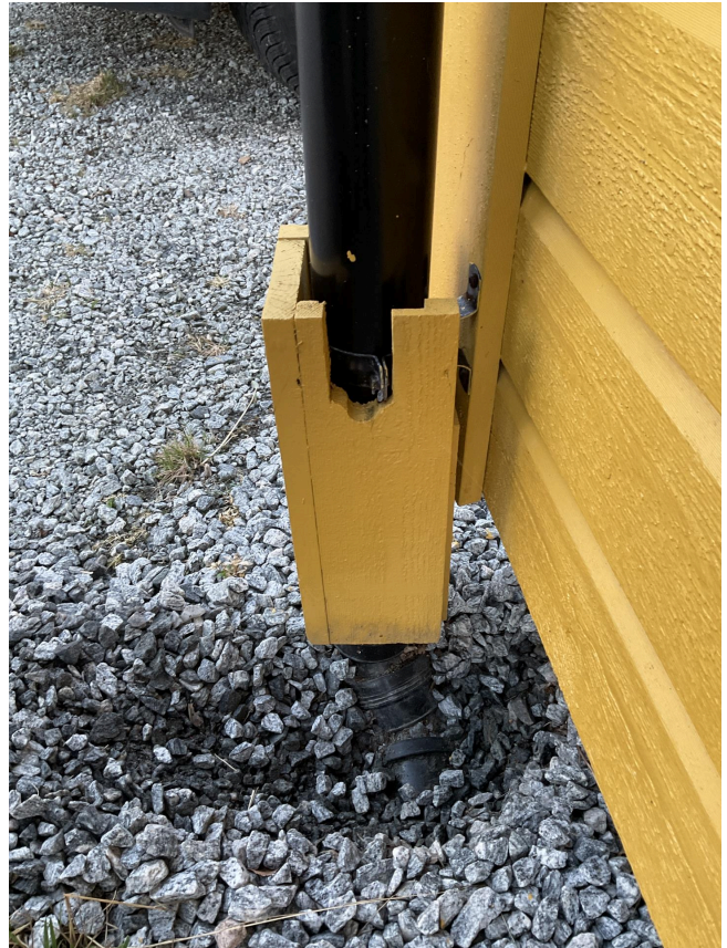
Nedløp satt kontrollert ned i grunna løp
