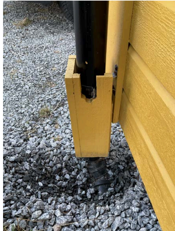
Nedløp satt kontrollert ned i grunna løp
