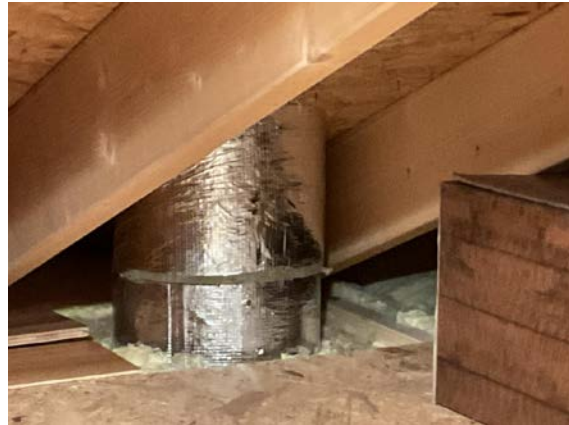
Røykeør på kaldloft/tilbygg
