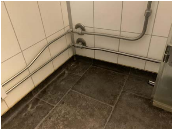
Gjennomgangsrør i dusjsone
