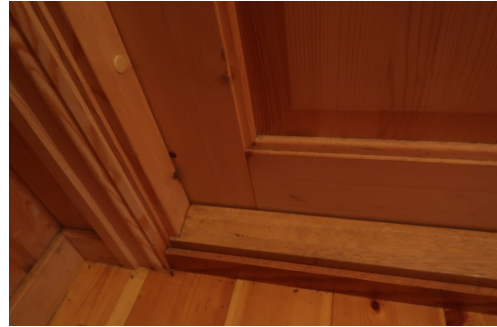
Bilde viser manglende spalte under innerdør for tilluft til badet
