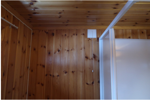
Bilde viser veggventil
