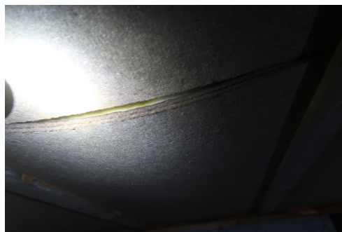
Bilde viser utettheter og synlig isolasjon
