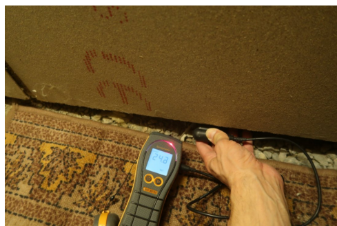
Bilde viser fuktmåling i nedkant av utlektet vegg under entré og bad.
