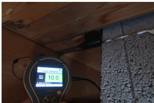
Fuktmåling ved fuktskjolder ved skorstein. Ikke skadelig fukt på befaringsdagen
