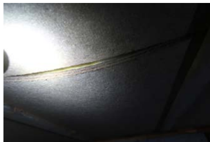
Bilde viser utettheter og synlig isolasjon
