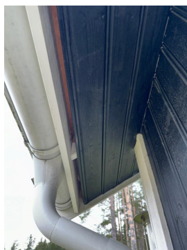
Utsykkende sannsynlig lufterør i gavlspiss
