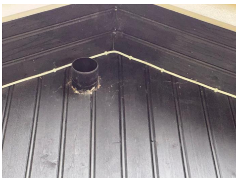
Utsykkende sannsynlig lufterør i gavlspiss
