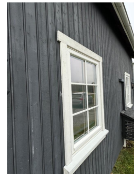
Vinduer med kun vannbrett under
