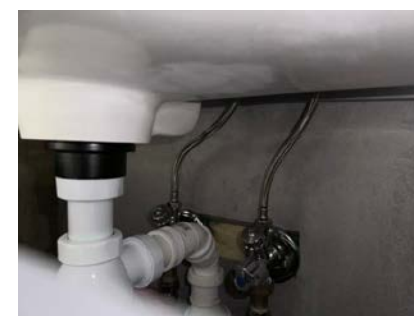
Hull i våtromsplate under servant (utett våtsone)
