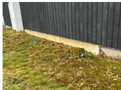
Grunnmur delvis forblendet med isopor.
