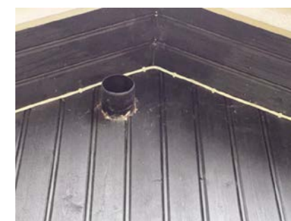
Ustikkende sannsynlig lufterør i gavlspiss
