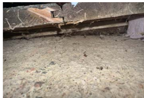
Liten/ingen luftning bak kledning
