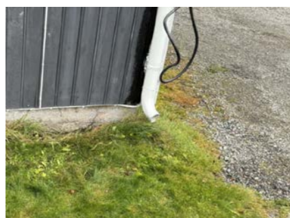
Takrennedløp kun med utkast.
