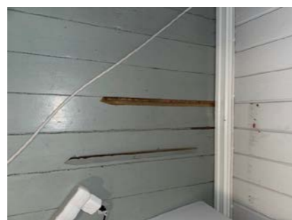
Ufagmessige avslutninger på innvendig platekledning og belistning.
