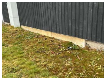
Grunnmur delvis forblendet med isopor.
