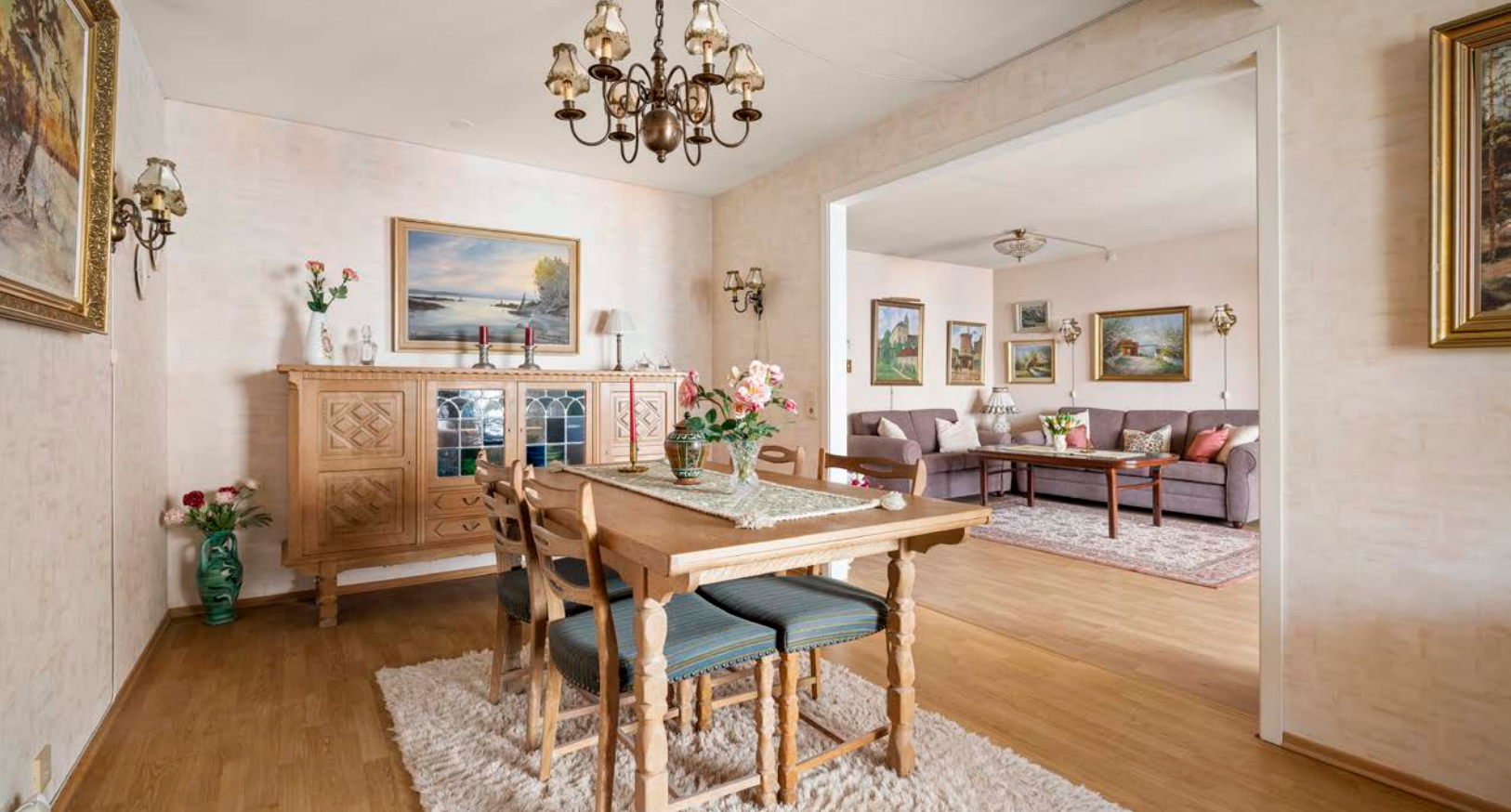
Spisestuen har lamiant på gulv, tapet på veggene og hovedsakelig skjult elektrisk anlegg.
