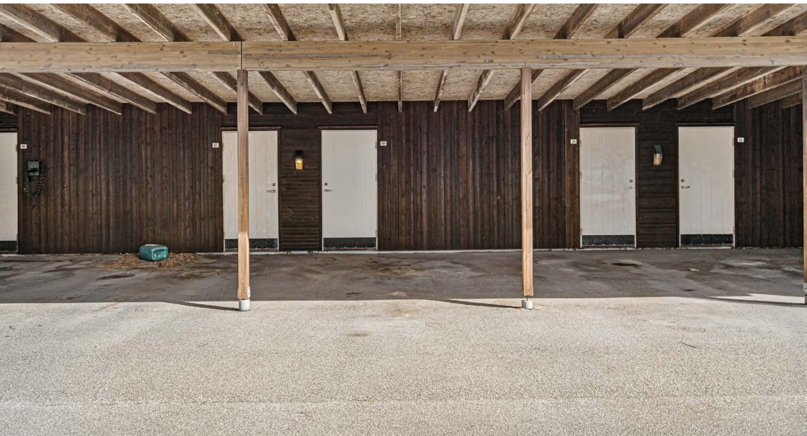
Parkering i carport og sportsbod i bakkant.
