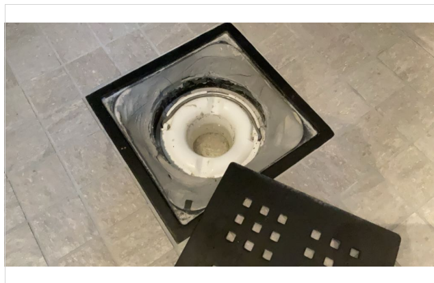
Kontroll av sluk.
