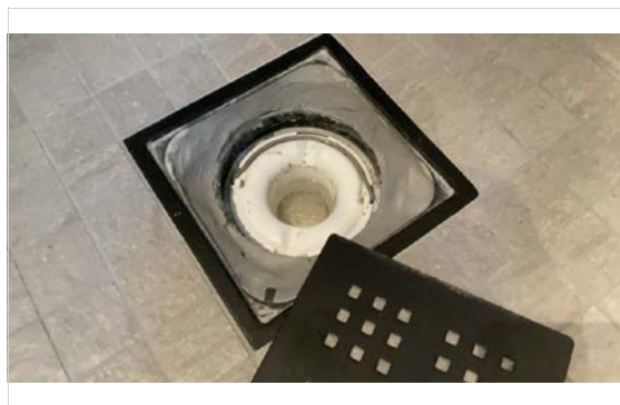
Kontroll av sluk.
