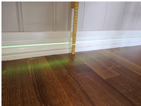
Etasjeskillet er kontrollert med nivelleringslaser.
