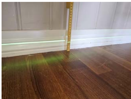
Etasjeskillet er kontrollert med nivelleringslaser.
