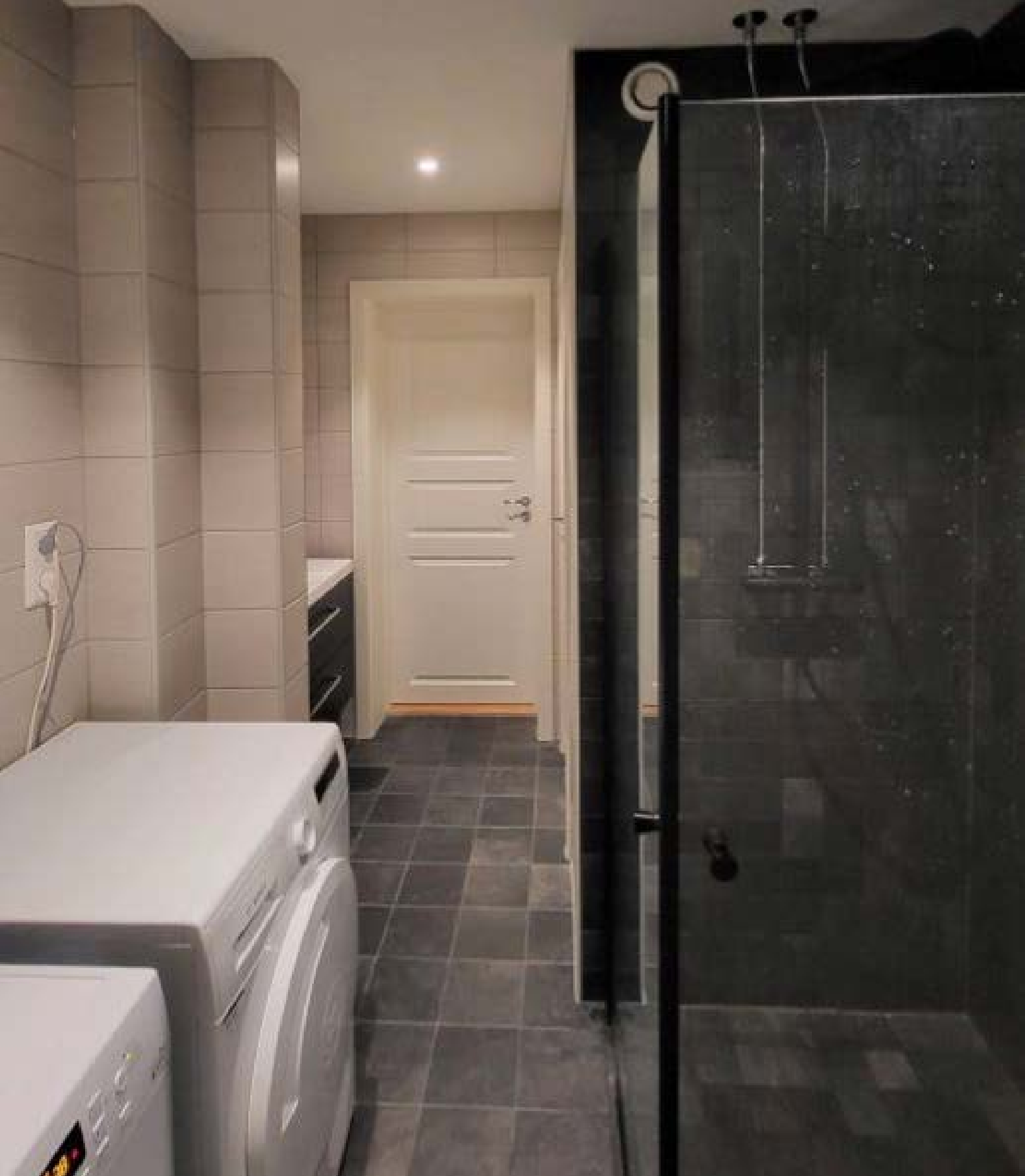
Flislagt bad pusset opp i regi av borettslaget i 2024. Rommet er utstyrt med dusjhjørne med vegghengt dusjbatteri med regnfall.
