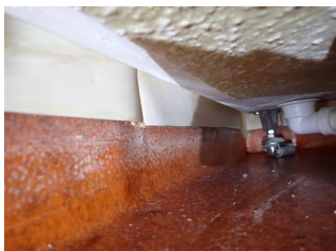
Skader i bunn av plater
