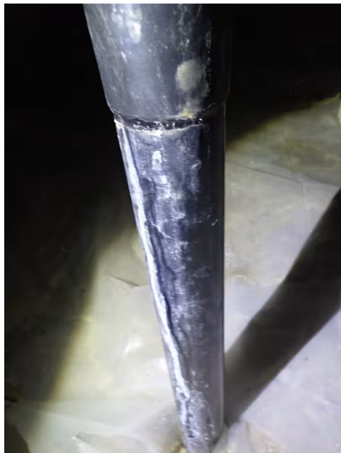
Rør i krypkjeller
