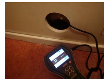
Ingen fuktutslag i vegg
