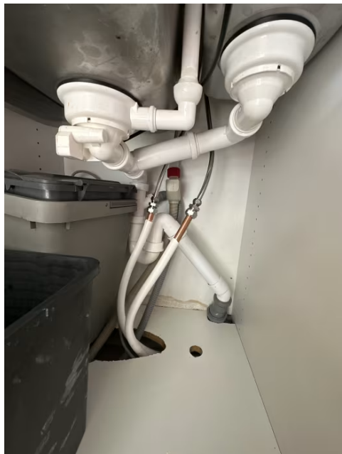
Viser vann og avløpsinstallasjoner under kum.
