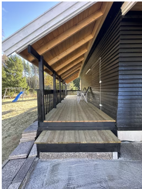
Viser overbygget terrasse.
