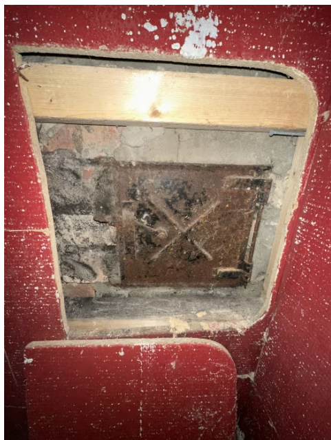
Viser sotluke i kjeller.
