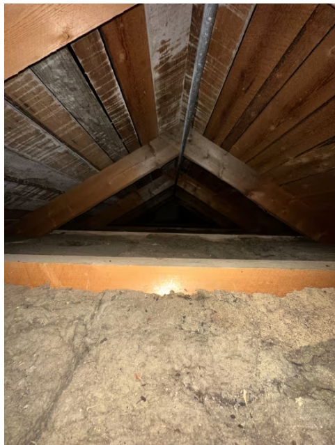
Viser kaldtloft, bildet tatt fra luke i himling på soverom.
