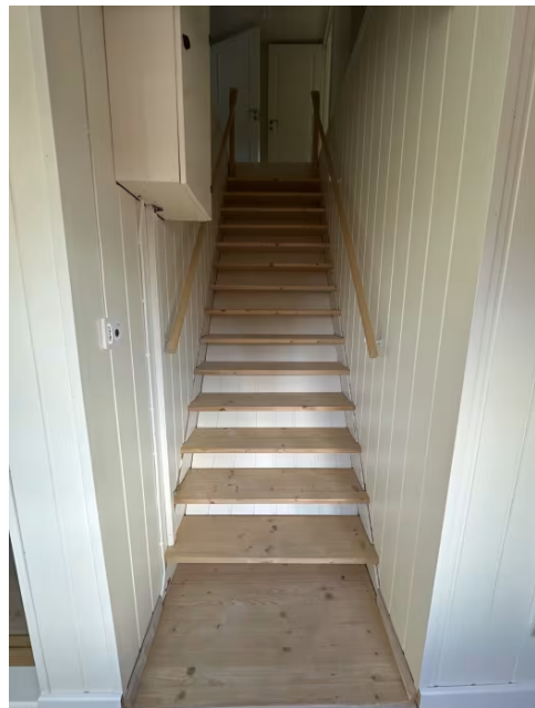
Viser trapp i mellom 1 og 2.etasje
