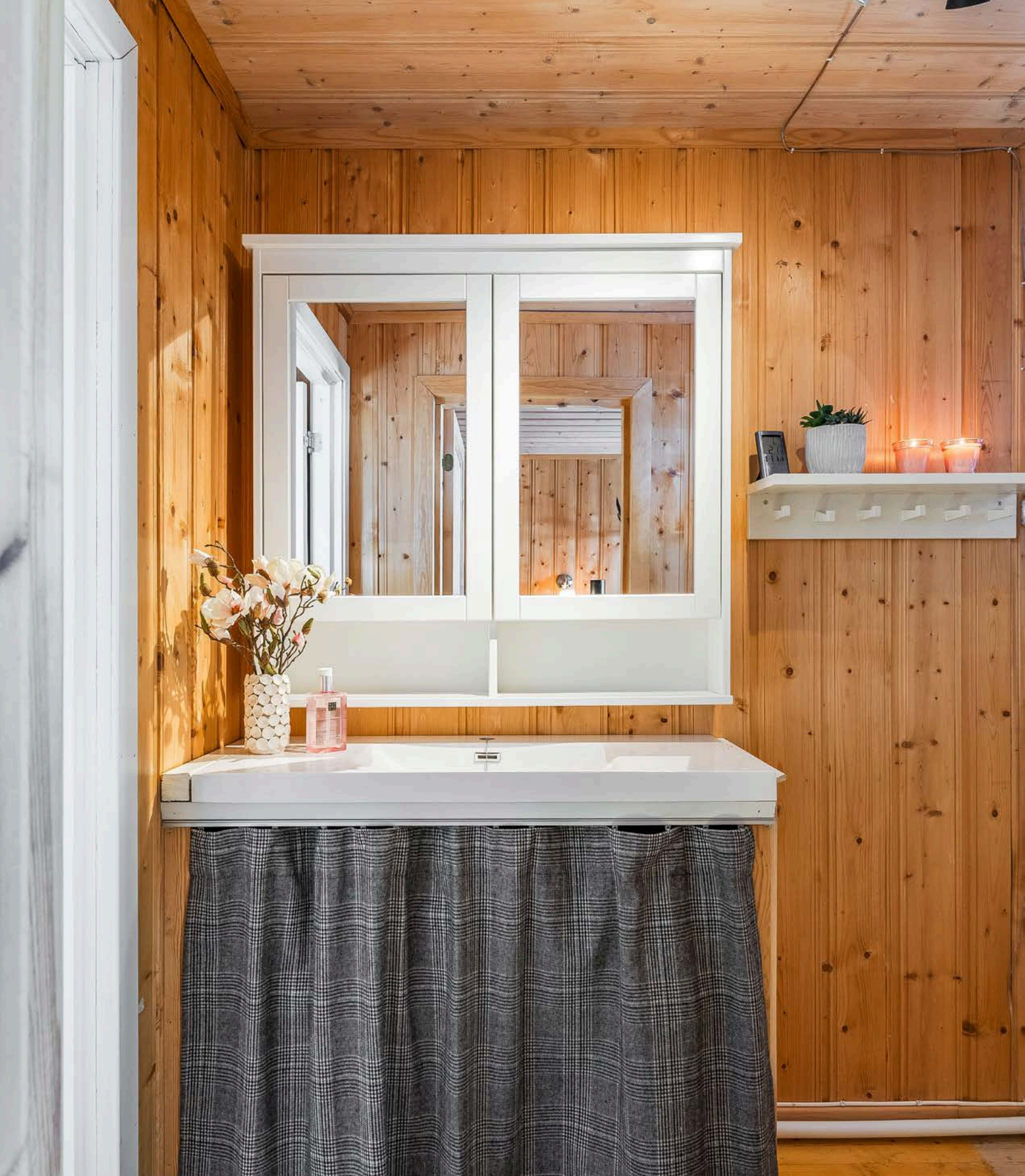
Sanitærrømmet har heltre gulv, panel på veggene, innredning med servant og vegghengt speilskap over.
