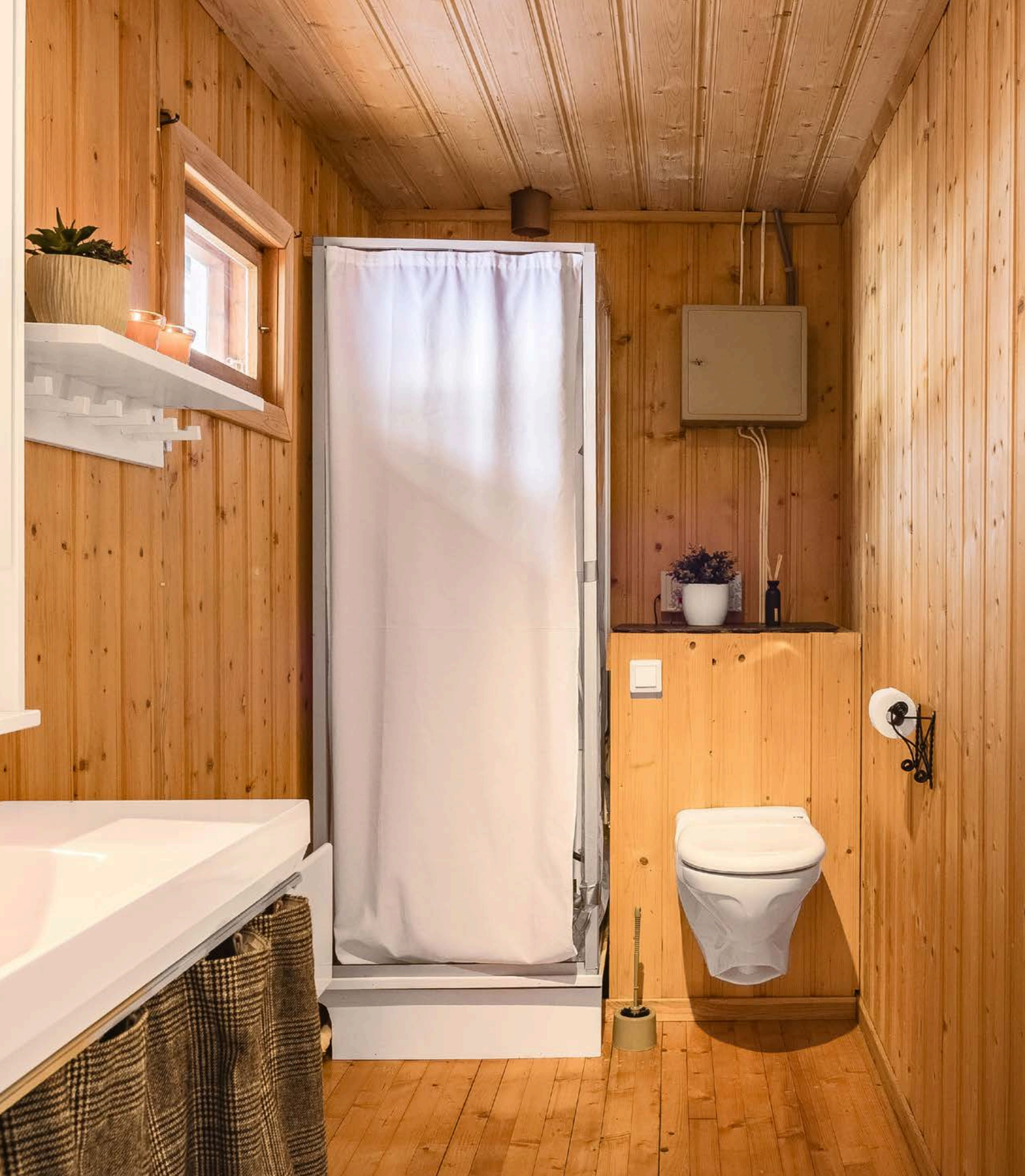
Rommet har dusjkabinett og vacuumklosset med utvendig tank. Kabinett og wc får vann fra kanne via pumpe.
