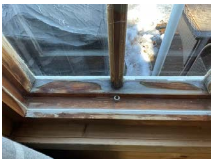
Fuktskjolder i mellom glass.
