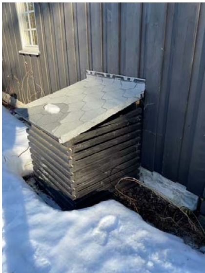
Utvendig tank til klosett.
