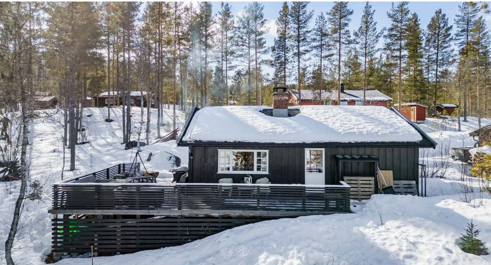
Hytta er vedlikeholdt med bla. nytt tak, vindskier og terrasse ved inngang i 2020. Terrassen utenfor stuen var ny i 2016.
