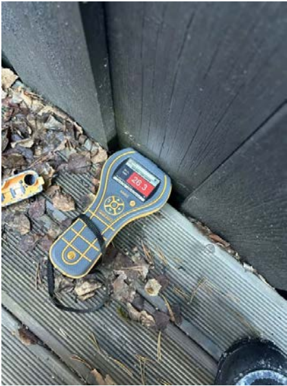
Fuktmåling i kledning ved terrasse
