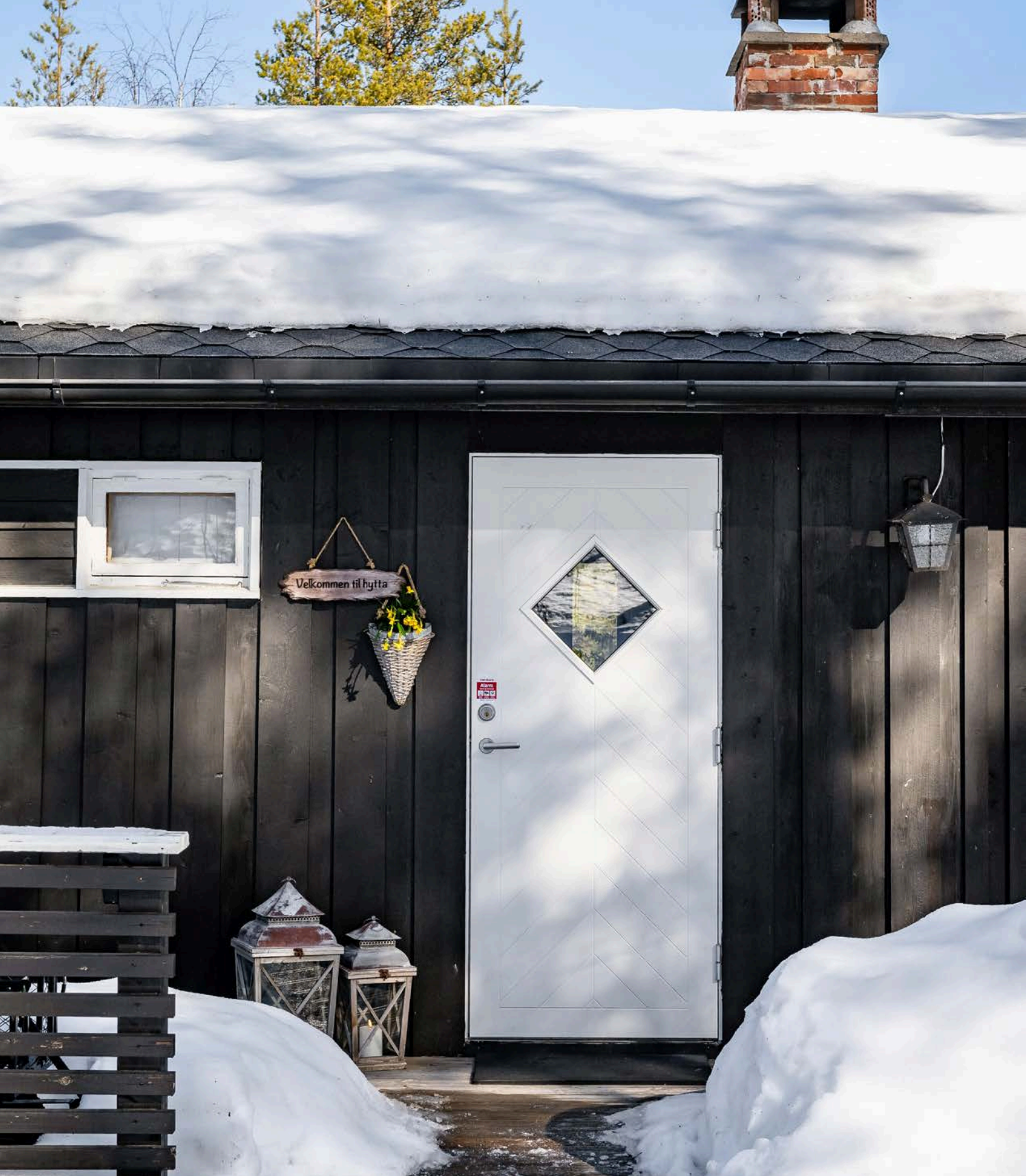
Hytta har stående sort tømmermannskledning og et hyggelig inngangsparti med terrasse.
