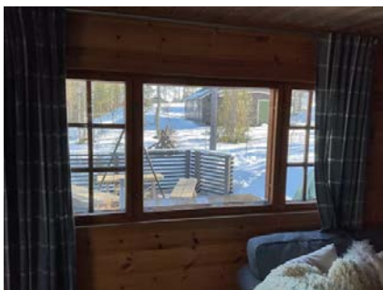
Vindu fra byggeår
