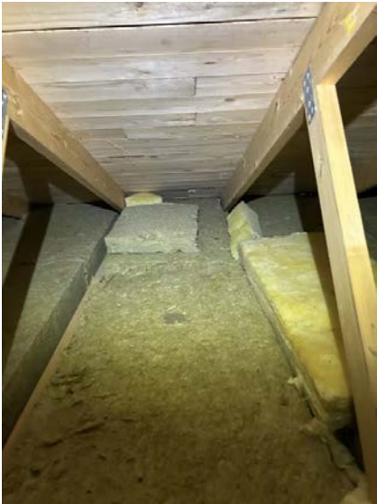
Tett lufting mot raft.
