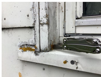
Omremming er ført helt ned til vannbrett, og dette har stedvis ført til råteskader.
