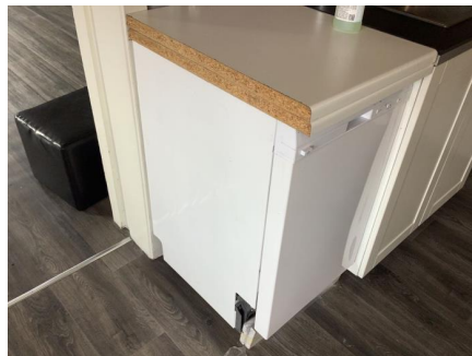
Kantlist og dekkside mangler.
