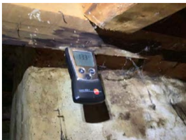
Fuktskjolder rundt pipe, og det måles tørt.
