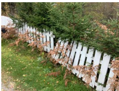
Gjerdet raser ut i skråning.
