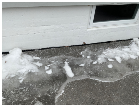
Grunnmur på endeveggen under stuen
