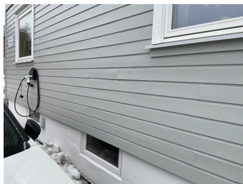
Utvendig trepanel på endeveggen
