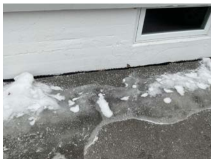
Grunnmur på endeveggen under stuen
