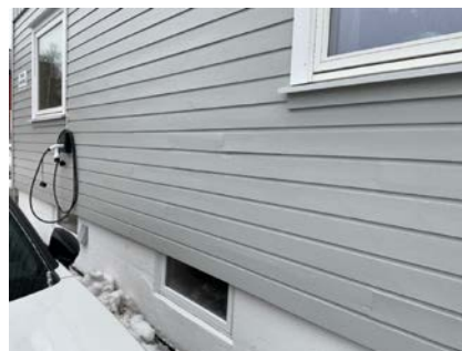
Utvendig trepanel på endeveggen
