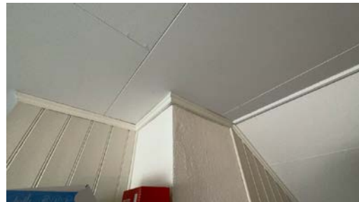
Utsnitt pipegjennomføring.
