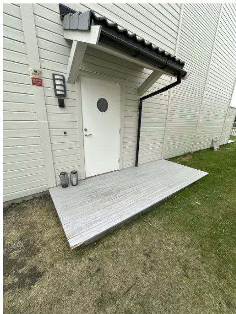
Delvis overbygget terrasse ved inngang.
