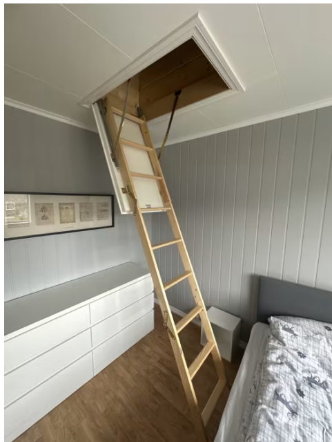
Adkomst til loft via luke med stige.
