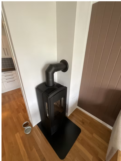
Viser ildsted og sotluke montert i stue.
