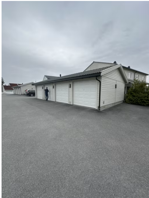
Viser felles garasjeanlegg.
