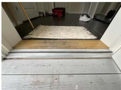
Det er ufullstendig beslag under inngangsdør.
