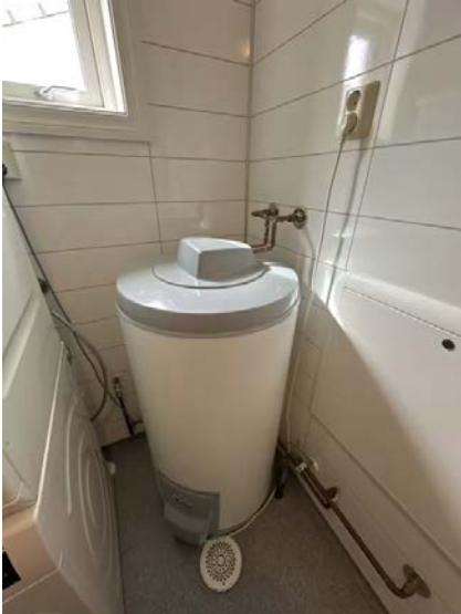
Viser bereder plassert på toalettrom/vaskerom.
