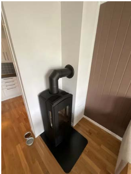
Viser ildsted og sotluke montert i stue.
