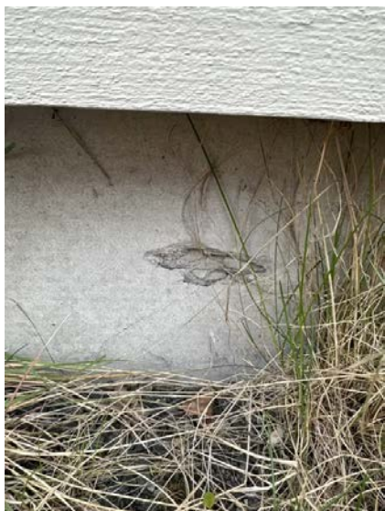
Viser riss i grunnmursplate.
