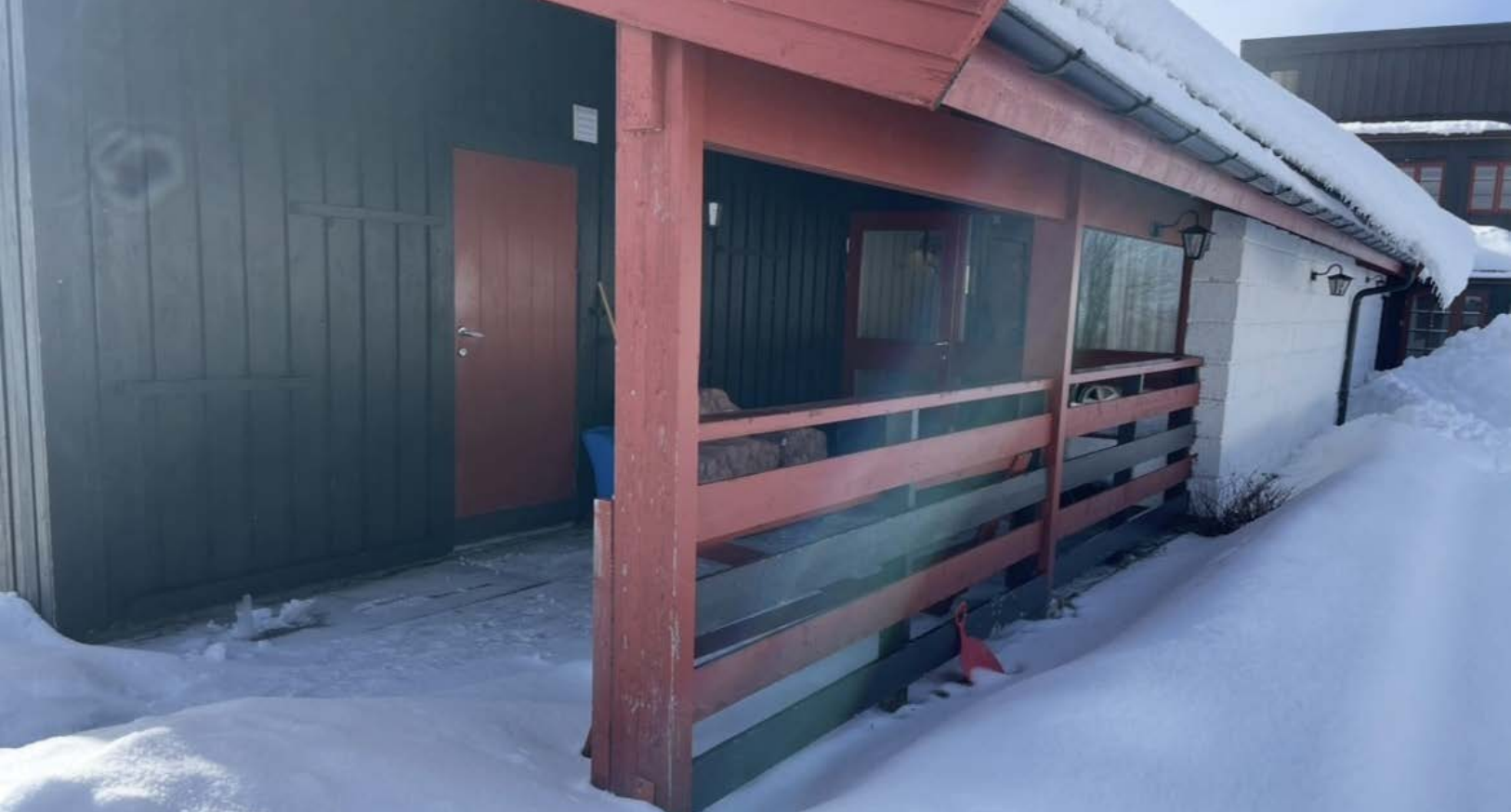
Inn døren til venstre er det mulig å prøppe og oppbevar ski.
