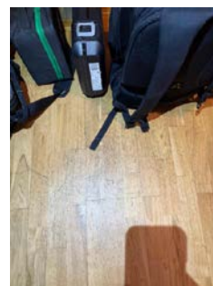
Bilder viser området ved inngangsdøren med større slitasje.
