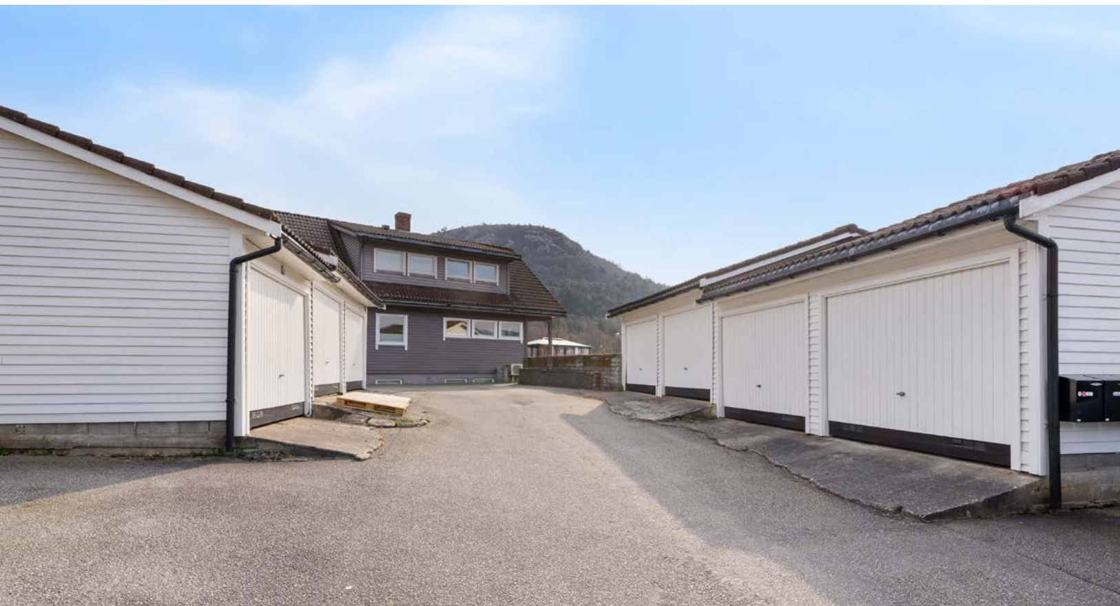
Garasje i rekke i tillegg til parkering i gårdsrom.
