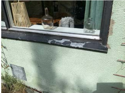
Vindusbeslag flasser i overflatebehandlingen
