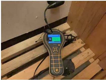
Fultmåling i delevegg mellom bad og bod i underetasjen.
