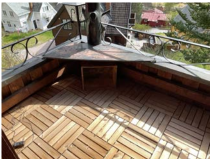
Lavt rekkverk på lufteveranda utenfor stuen.
