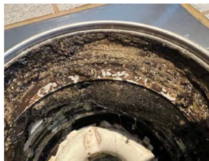
Synlig slukmansjett korrekt under klemring i sluk
