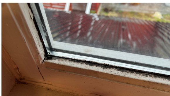
Baderomsvinduet i 2. etasje
