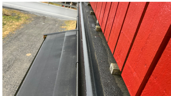
Membran av takpapp på veranda i 2. etasje
