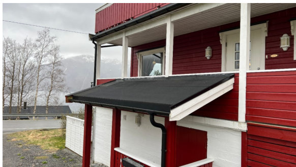
Tekking av takpapp
