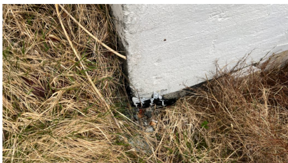
Grunnmur med utvendig fuktsikring
