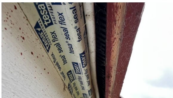
Luftet bordkledning. Musebånd er montert på kontrollert område
