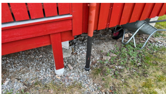
Nedløp ført ned i rør i grunnen
