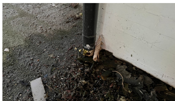
Utett overgang fra nedløp og rør i grunnen
