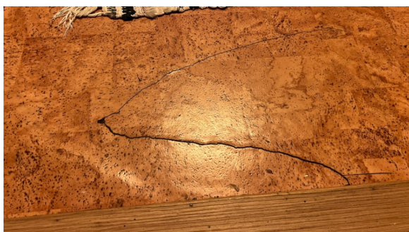
Sprekk i gulvbelegget
